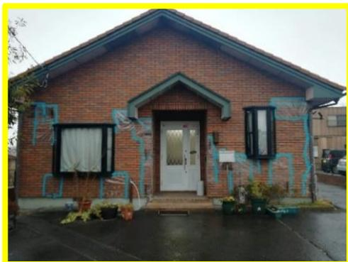
地震で事務所・作業場を兼ねた本棟の外壁・内壁に無数の亀裂が生じ、ドアが開かなくなったほか、デスクトップPCなどの備品が壊れました。翌14日の日曜日に職員が総出で滅茶苦茶になった室内を片付け、外壁にテープを貼って応急処置をしたうえで、週明けに活動を再開しました。
