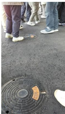
マンホールトイレ
