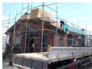
7月21日～ 屋根の改修工事：瓦屋根を外し、軽量化するためアスファルトシングルに張り替える作業。屋根工事は、(有)仙南瓦工業さんにお世話になり、雪対策も施していただきました。
