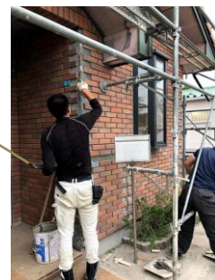
7月6日～ 室内のクロスの張替え・外壁の壊れたレンガタイルはがし。室内のクロス張り替え工事と、外壁の壊れたタイルを剥がす作業が本格的に始まりました。暑い中の作業で、現場の職人さん達も疲労困憊の様子でした。思った以上に内壁の被害状況が大きかったようで、クロス職人半澤さんにも大変お世話になりました。
