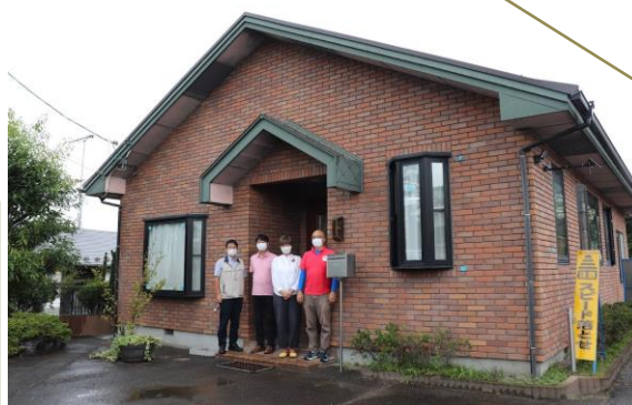
室内・外壁・屋根の改修+耐震強化プロジェクト完了！
